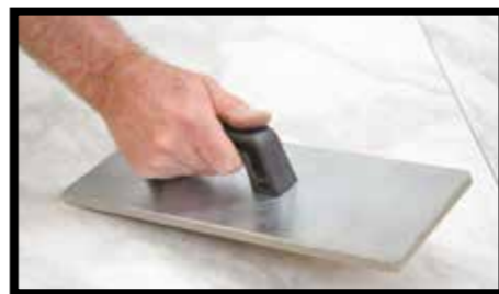
Fig.30 - Après la pose de la dalle, faire adhérer le mortier-adhésif en tout point afin d'éviter la formation de vides et de bulles d'air. Pour ce faire, utiliser des taloches caoutchoutées (par exemple Raimondi "142G").
