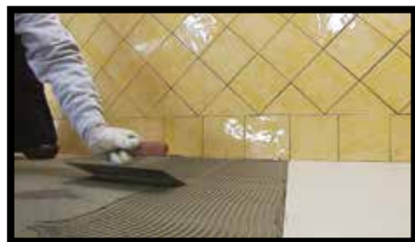
Fig.28 - Cette technique n'est indiquée que pour les mortiers-adhésifs dont la fiche spécifie qu'elles sont adaptées à la pose par "simple encollage". Étendre le mortier-adhésif sur toute la surface du support. Suivre les indications du producteur en ce qui concerne le choix de la spatule et le mode d'étalement.
