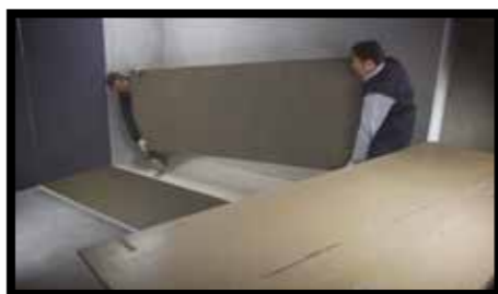
Fig.31 - Il faut tout d'abord les déplacer dans le sens vertical, en les agrippant par le bord supérieur puis se déplacer en les tenant toujours bien droites à l'aide, si nécessaire, d'une deuxième personne.
